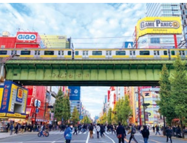
↑秋葉原駅前、中央通りを跨ぐ総武線の高いガードはアキバのランドマーク
