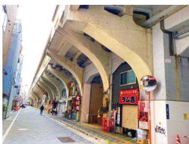
④ 浅草橋駅ホームを支えるカンチレバー構造。ガード下は問屋街になっている
