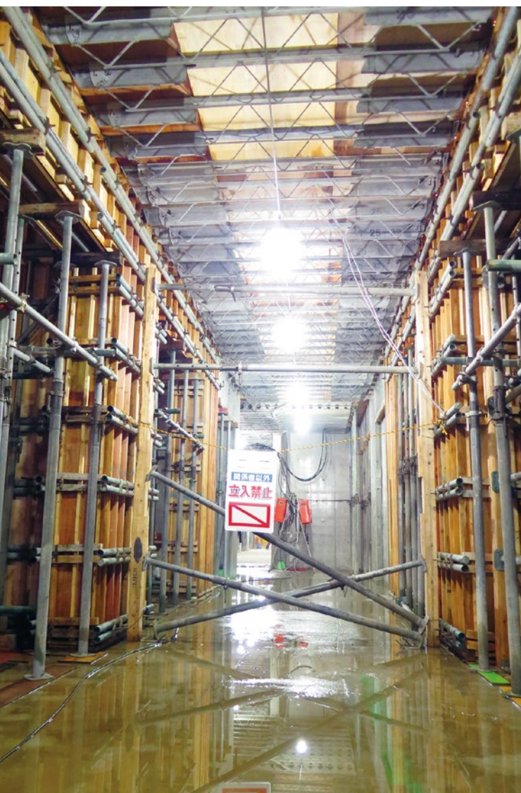
型枠支保工解体作業時の現場発生音の低減を期待してコンクリート型枠水平支保梁材(上)を採用。作業などのスペースを広くすることができる
