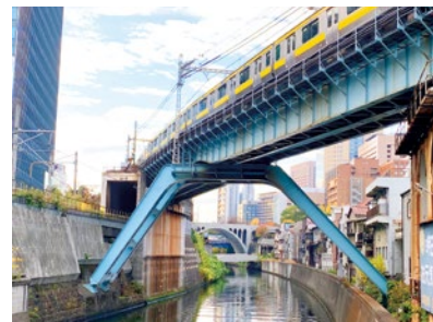
↑松住町架道橋の先で電車は神田川橋梁を渡り御茶ノ水駅へ向かう
