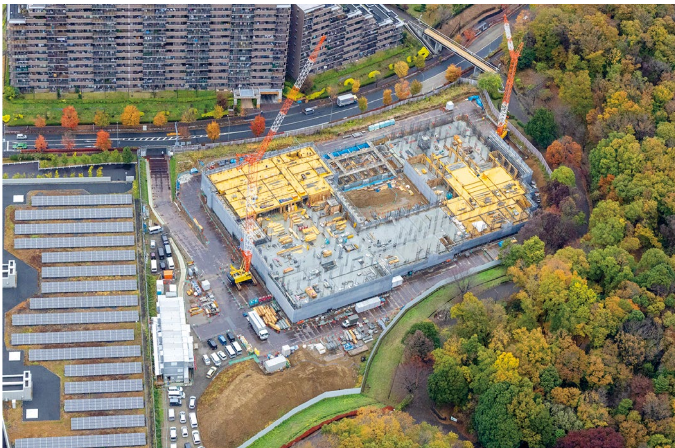
📍22年11月末現在の現場。一部の工区では3階床部分の配筋工事と型枠工事が進んでいる(全景撮影＝㈱エスエス)
