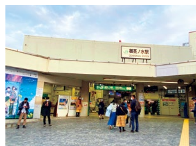
↑御茶ノ水駅西口には1932年築の駅舎が残るが、こちらも解体予定
