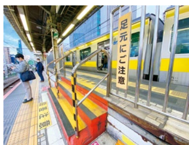
↑御茶ノ水駅の秋葉原側、総武線と中央線ホームの間には微妙な段差が存在
