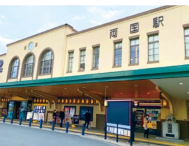
① 1929年築の両国駅の駅舎。房総方面への終着駅の面影を留めている
