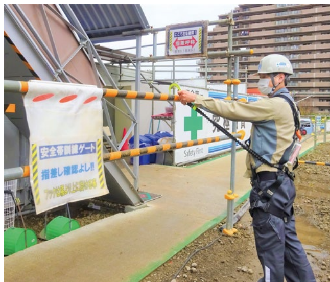
朝礼台の横に安全帯訓練ゲートを設置
