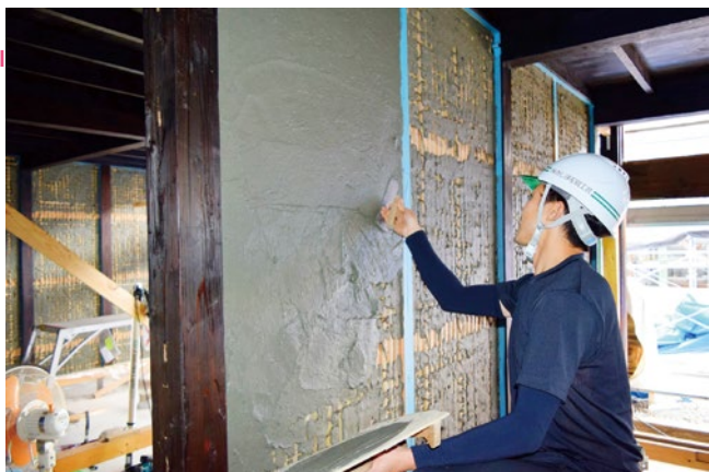
↑ 埼玉県川越市の市指定文化財である旧川越織物市場の復元工事で、下塗りの荒壁土を塗る若手の職人
