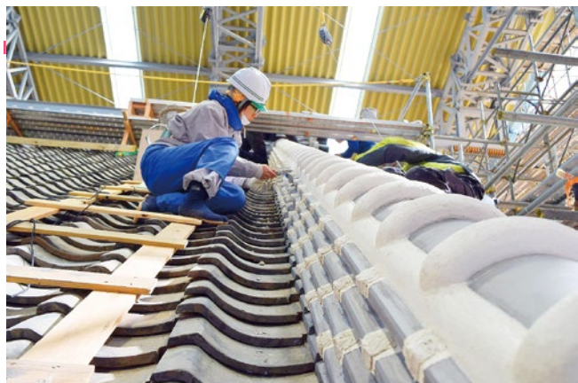
↑ 国宝で世界遺産の旧富岡製糸場の保存修理工事で、屋根漆喰を手掛ける女性若手職人
