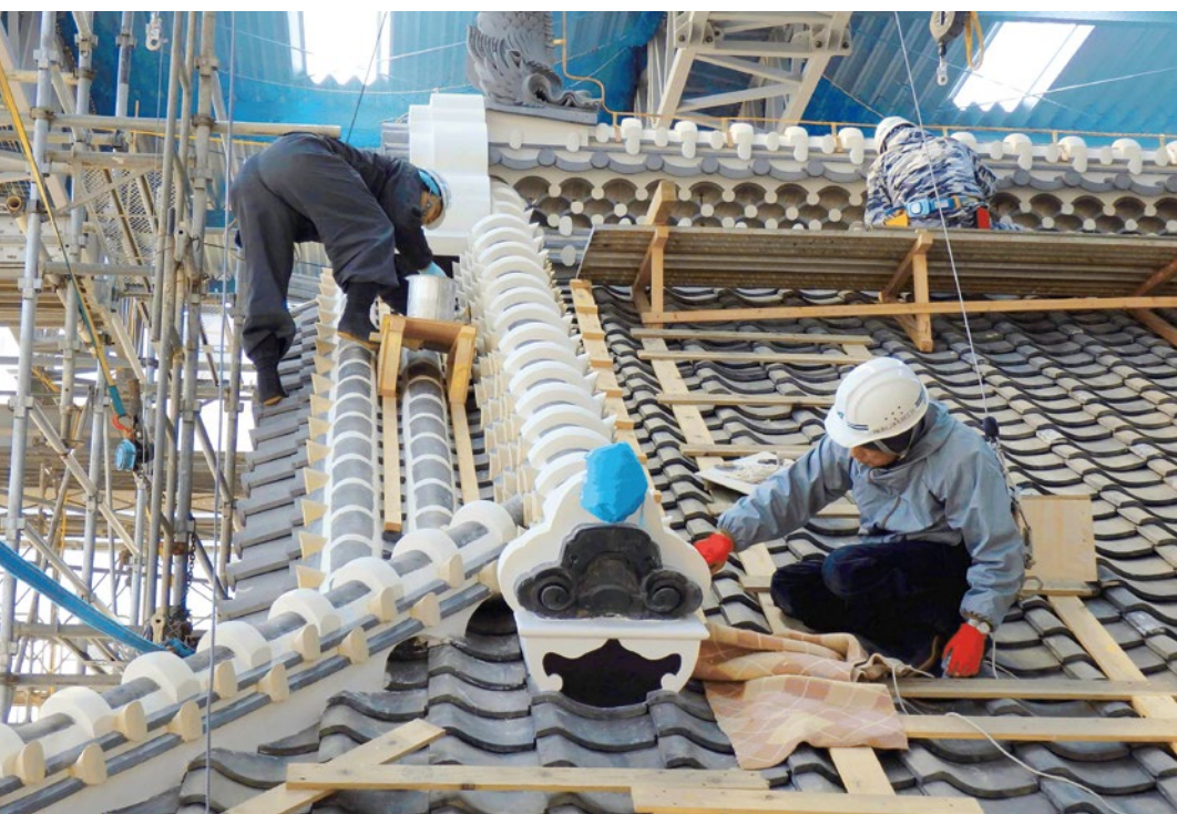
国指定の重要文化財である成田山新勝寺額堂の耐震補強整備での屋根漆喰工事
