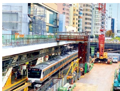
↑現在リニューアル工事が進む御茶ノ水駅
