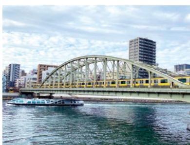
② 総武線隅田川橋梁。田中豊が設計を担当したランガー桁様式
