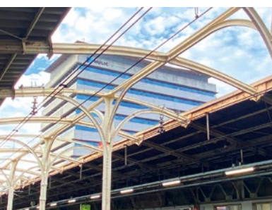
③ 浅草橋駅構内の架線柱は、古レールを用いている
