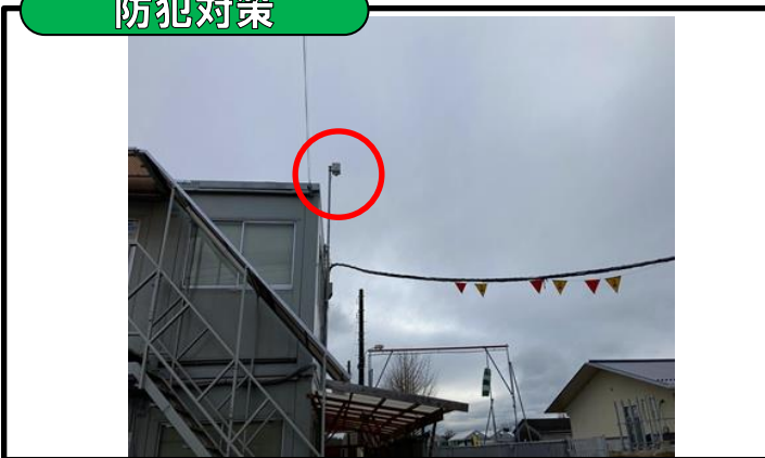
工事エリア監視カメラ設置
