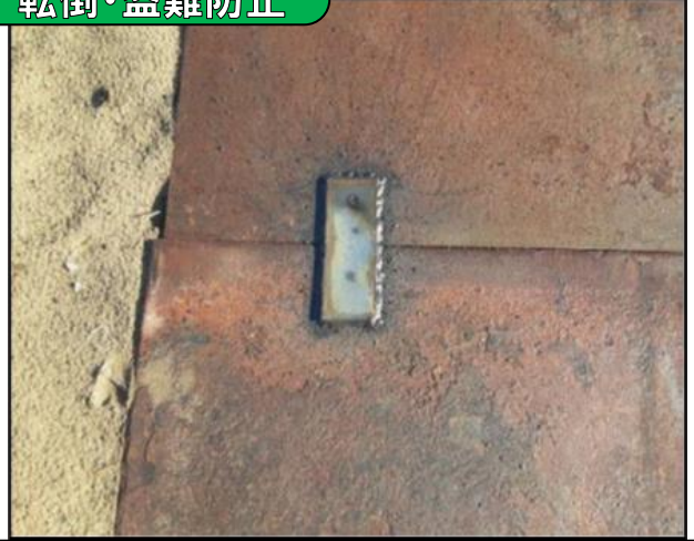
敷鉄板のずれ止め措置の実施
