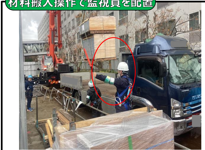
クレーンによる材料搬入操作中に 監視人を配置
