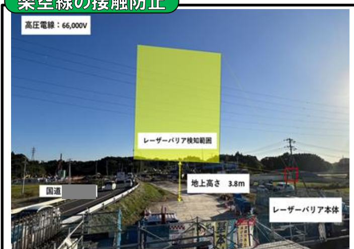
レーザーバリアシステムの採用
