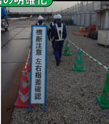
作業員通路の明確化
