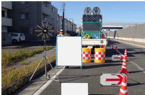
誘導員を安全な位置に配置し、規制材も規制の実施が明確に伝わるよう配置を見直し（誘導員の視認性は改善の余地有り）
