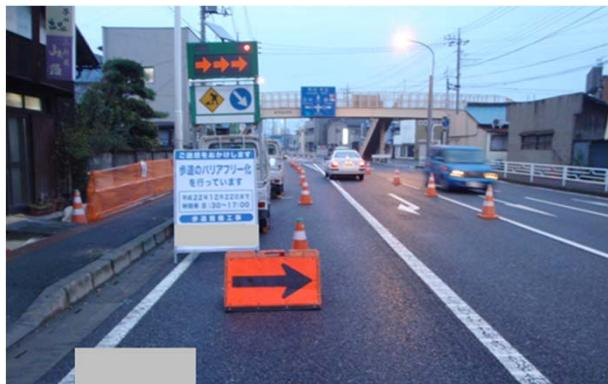
規制材の配置を見直し、導流部の矢印看板や工事看板が見やすいよう設置
