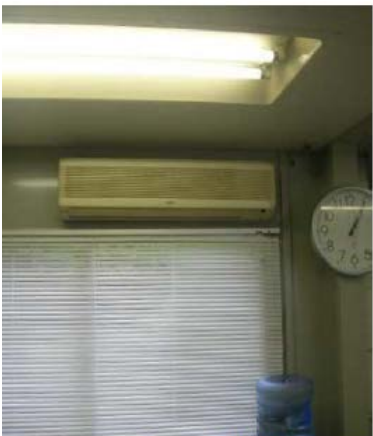
▲エアコン設置
