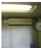
▲エアコン設置
