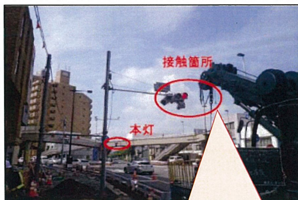
杭打ち機移動中、信号機に接触
