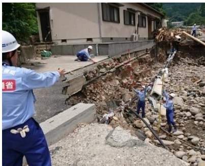
河川被害状況の調査
