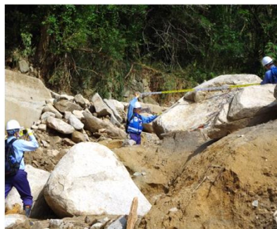
土砂災害被害状況の調査
