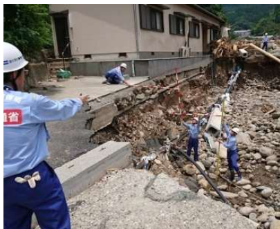
河川被害状況の調査
