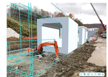
掘削作業時にARと比較
