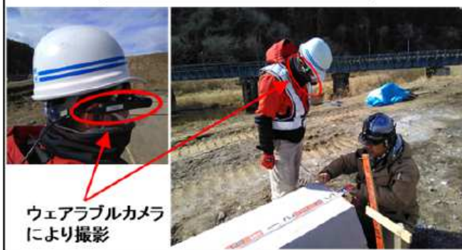
現場での受注者による撮影状況
