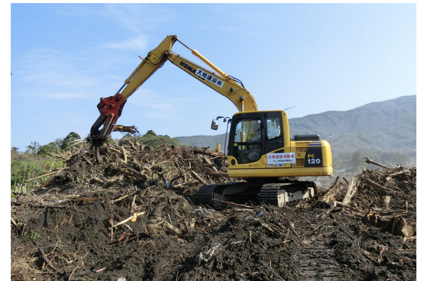
伊豆大島での豪雨災害復旧活動の様子
