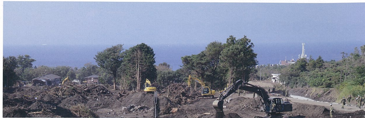
家屋・施設を倒し流れた土石・木を、自衛隊や建設企業の重機が協力して除去に当たる
