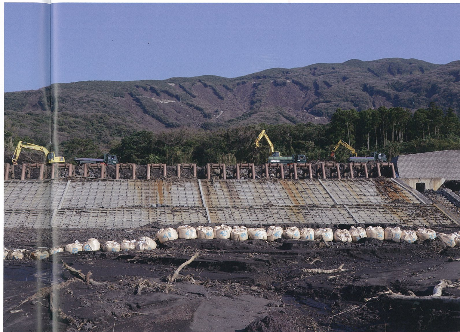
山肌から崩れ落ちた大規模泥流を抑えた大金沢本川堆積工。しかし土石流はこれら堰堤の無い場所を縫うようにして通り、家屋をのみこんで海まで達した
