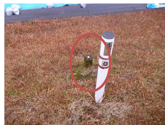
基準点設置状況
