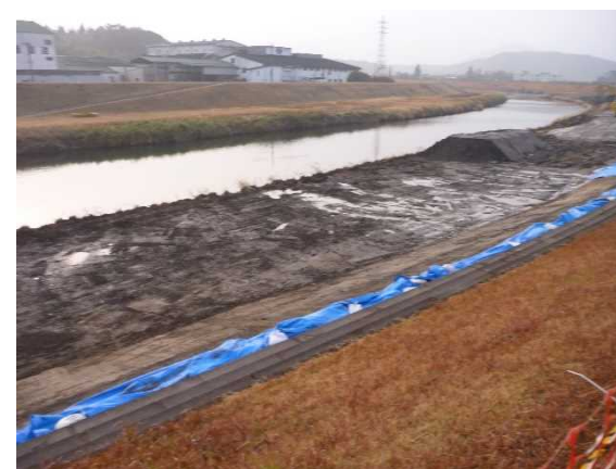
計測対象箇所(終点側)
