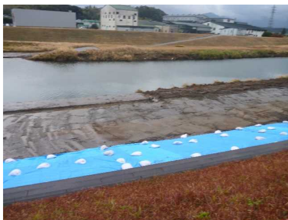
計測対象箇所(平場部)
