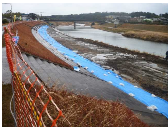
計測対象箇所(終点側)
