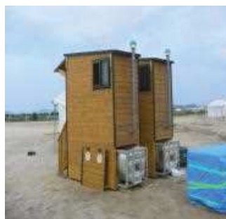
換気扇があり、トイレ本体は後ろに引出メンテが可能です。
