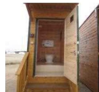
便器は洋式で非水洗です。 中央に制御盤があり人が入ると照明が点灯します。
