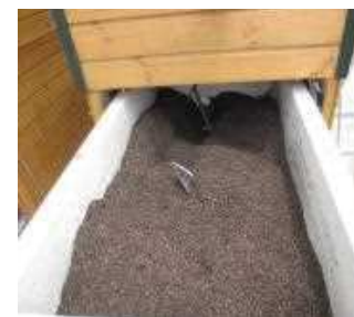
中には特殊加工したチップと土壌菌類が入っています。 臭いを抑え、処理を速めております。 中に攪拌の棒が見えますが人が入っている場合は停止です。
