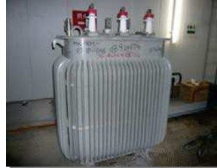
トランス (変圧器)
