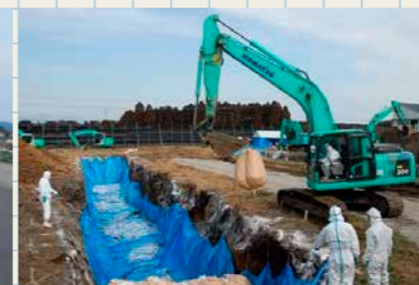
平成22年4月口蹄疫被害への対応 (宮崎県建設業協会)
