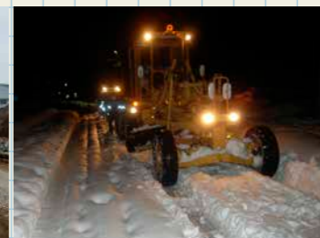
平成26年度豪雪への対応 (埼玉県建設業協会)
