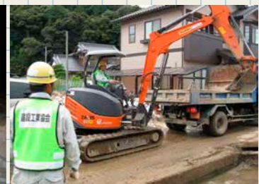
平成26年8月豪雨災害への対応 (広島県建設工業協会)
