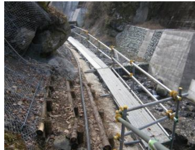
転落防止柵の設置
