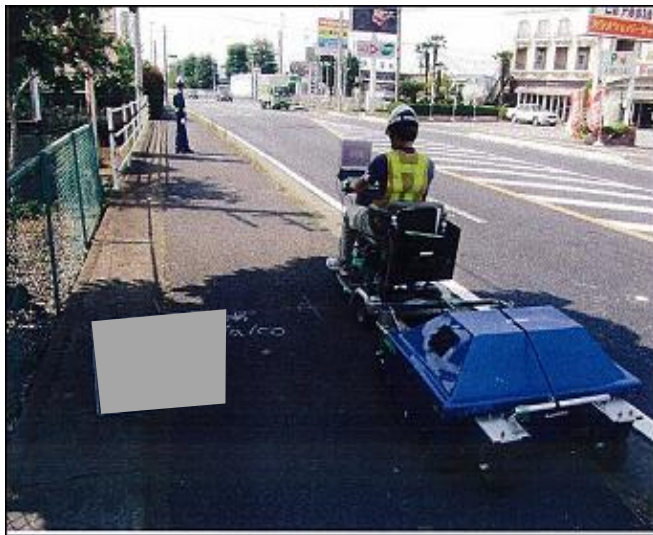
探査機による埋設管の確認作業
