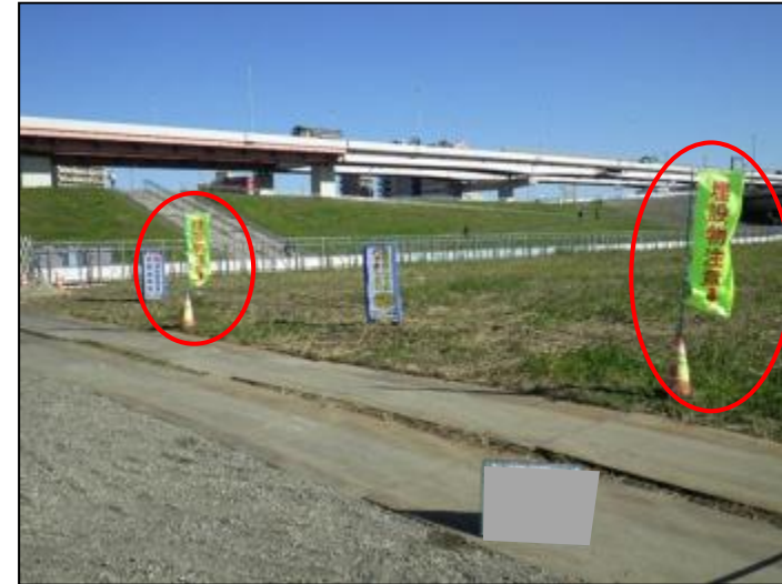
地下埋設物の目印表示(看板)
