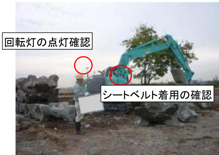
シートベルト着用やクレーンモード(回転灯の点灯確認)の確認
