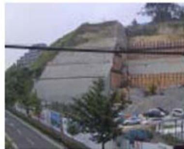
施行前 切土法面
